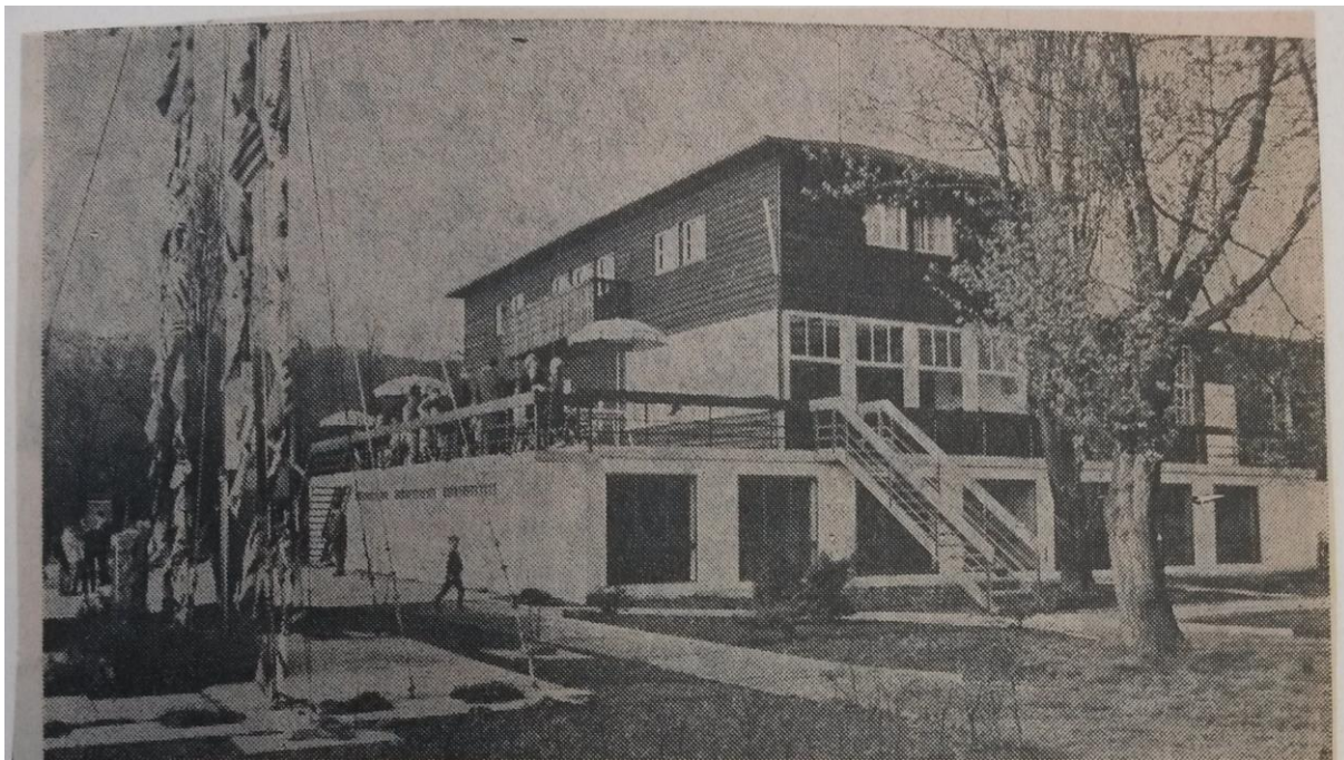
Das Bootshaus des RV Bochum ist erweitert worden. Zur Wasserseite hin entstand eine Bootshalle, deren 22 m lange Terrasse bei künftigen Regatten als ideale Tribüne verwendet wird. In der neuen Bootshalle ist Platz für neun Rennboote. (WAZ-Foto: W. K. Müller)
