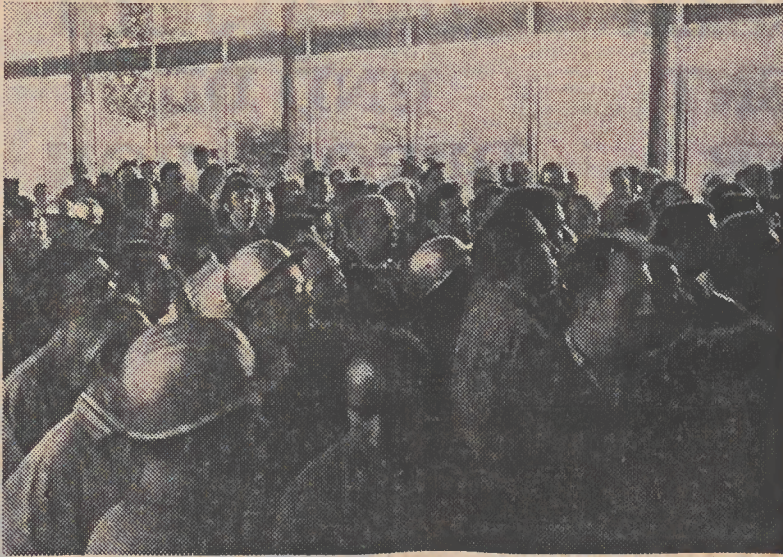
Im Verwaltungsgebäude wartete man auf die Stellungnahme des Vorstandes
